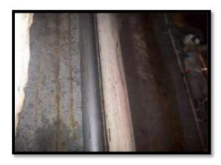
PREPARACION DE SUPERFICIE MECANICA Y QUIMICAMENTE: En la foto a la derecha, está el personal haciendo limpieza mecánicamente, se puede observar ya visibles las columnas de hierro, el pozo ya perdió parte de su concreto original y es donde nosotros protegeremos con el producto Milamar 2900LS.
